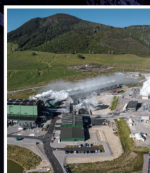
地熱発電プラント
