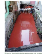
Sekolah di Kiaracondong, Bandung. Tolol sram (water flush) yang langsung diuruk ke saluran atau port.
