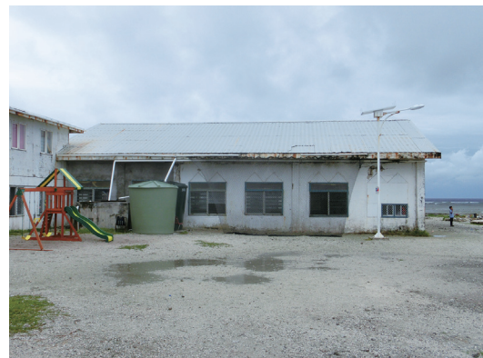
屋根からタンクに雨水を集めて利用
